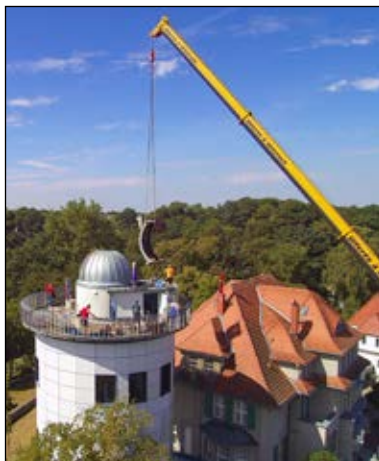
Per Lastenkrane schweben die Einzelteile der neuen Kuppel ein Foto: M. Wiegmann
